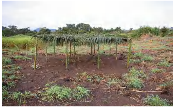
完成した東屋(ハンガー)
